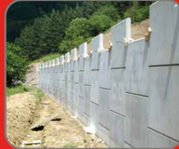
MUROS DE CONTENCIÓN
