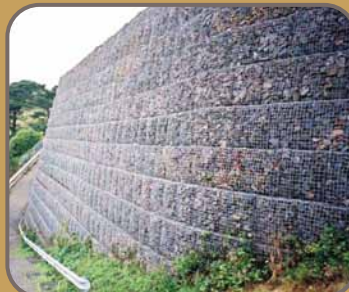
MUROS DE CONTENCIÓN
